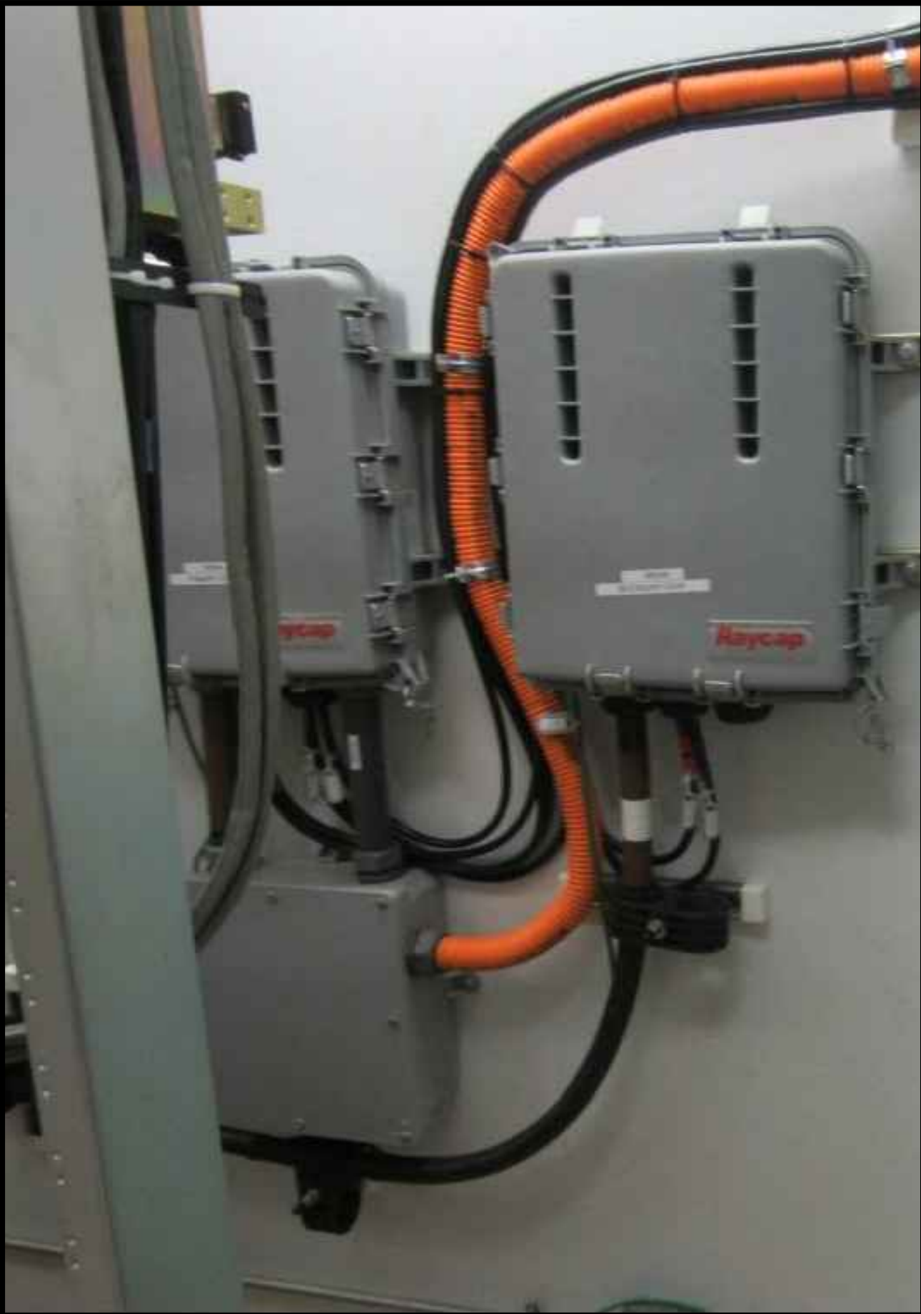
EXISTING RAYCAPS LOCATION SCALE: N.T.S.
